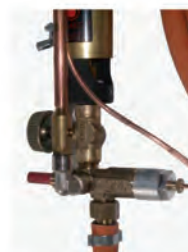
R440 détail sécurité brûleur sonde + veilleuse
